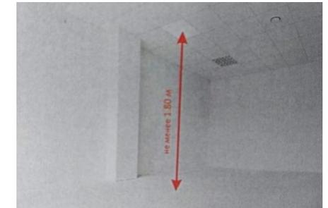
2. Установите обогреватель в каркас потолка ("Армстронг")
